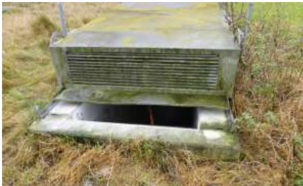
Eingangs-Treppe mit verschiebbarer Abdeckung. (Foto von 2014)
