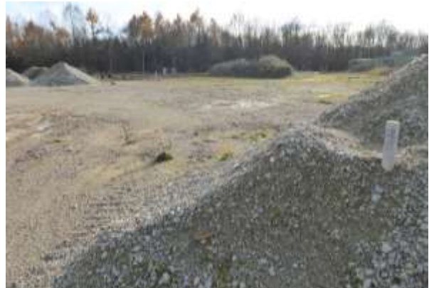
Rohböden und Erdmieten im Südostteil, Blick vom Nordrand nach Südwesten; hier wurden bereits Gebäude abgerissen, Asphaltflächen ausgebaut und Gehölze gerodet.
