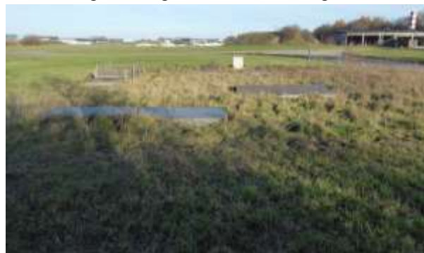
Diese „Keller“ wurden bereits 2014 besichtigt, sie sind dicht, glatt und für Fledermäuse nicht geeignet. Dort stand früher ein Stromgenerator.
