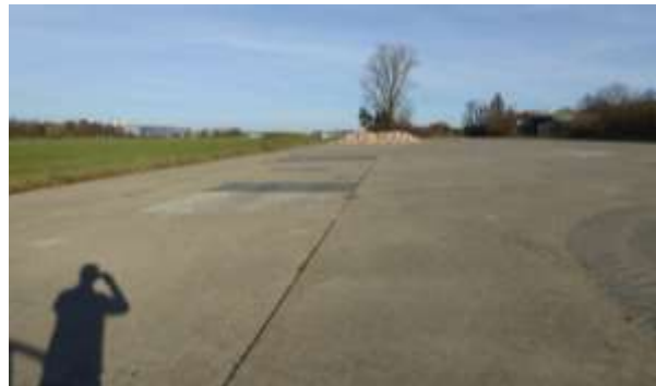
Blick von der Südwestecke nach Osten, mittig die große Pappel.
