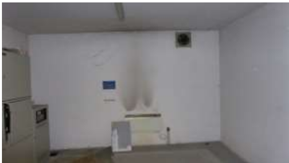
Ein weiterer Raum mit Wandöffnung, in die aber ein Ventilator eingebaut war. (Foto von 2014)
