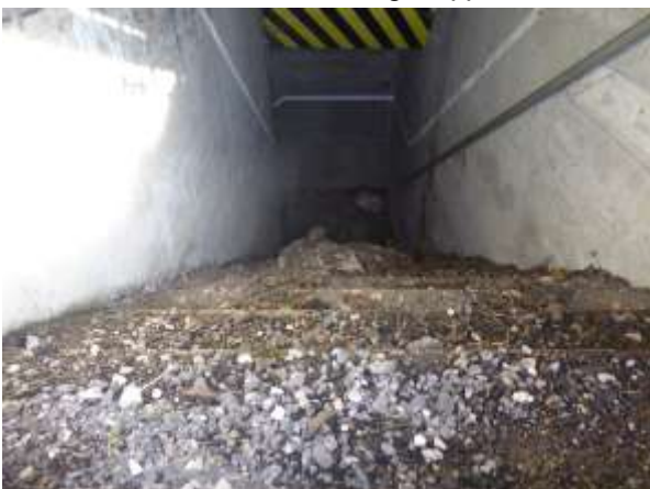
Blick durch den nur ca. 20 cm hohen Spalt in den „Keller“.
