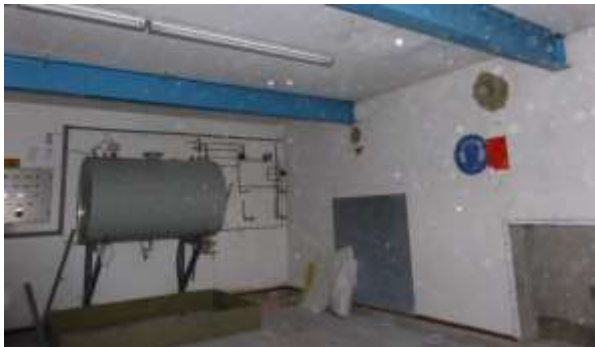
Ehemaliger Generator-Raum: Sauber, dicht, glatte Wände und Decken. (Foto von 2014)
